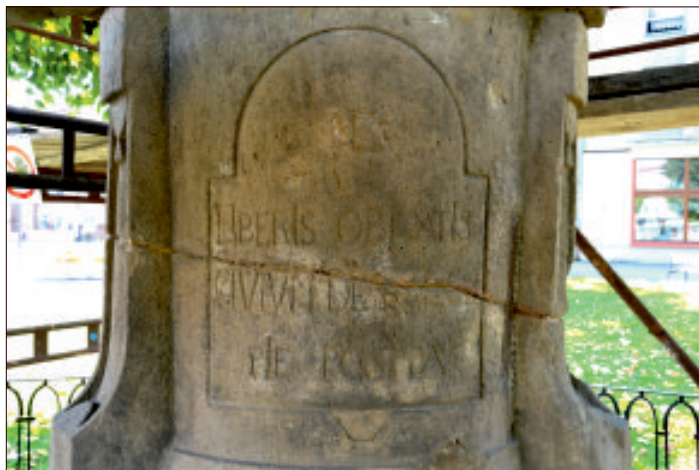
TRHLINA V PODSTAVCI
