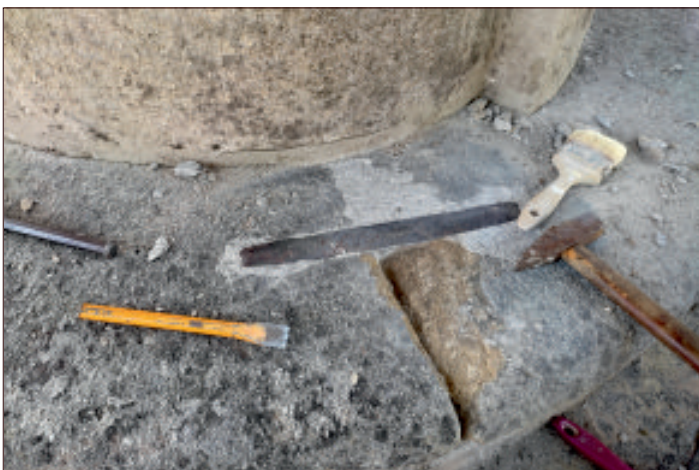
SCHODISKOVÉ STUPNE, ODSEKÁVANIE CEMENTOVÝCH TMELOV
