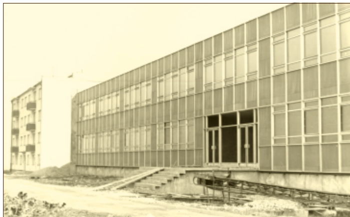
UČITEĽSKÁ BYTOVKA S NOVOU ZDŠ NA HOLLÉHO UL. V R. 1972
