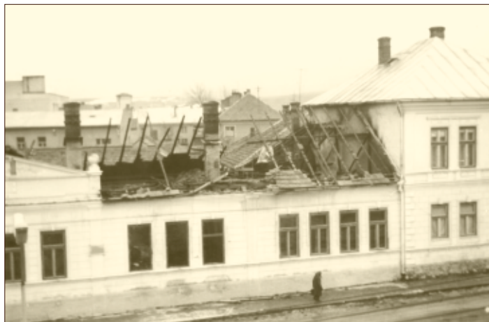
PO POŽIARI ZDŠ NA KAŠJAKOVEJ UL. (6.1.1970)
