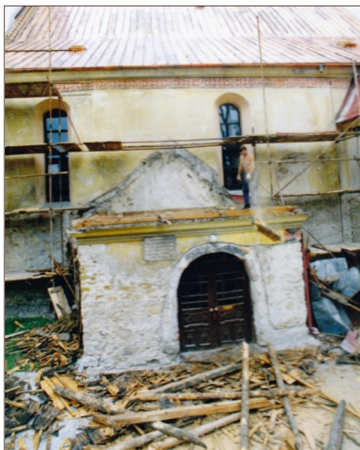
OPRAVA KOSTOLA V R. 1990
