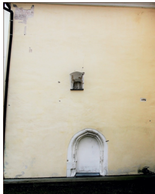
STAV PRED REŠTAUROVANÍM, HORE SONDA, KTORÁ ZACHYTLA KVADROVANIE (R. 2017)
