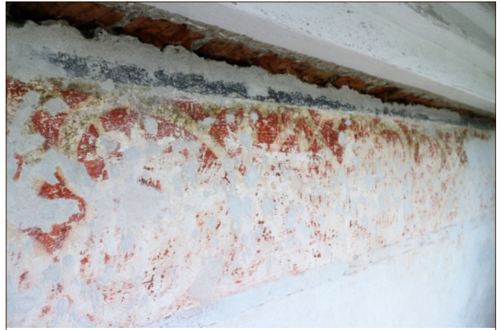
ŠABLÓNOVÝ PÁS PO VYTMELENÍ A DOČISTENÍ OD VÁPENNÝCH ZÁKALOV (R. 2017)
