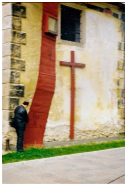
PANSKÁ EMPORA S PLASTICKÝM KVÁDROVANÍM A TERČOM V PODSTREŠNOM PÁSE R. 1990
