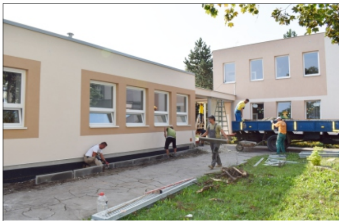
REKONŠTRUKCIA V MŠ NA MUDROCHOVEJ UL.
