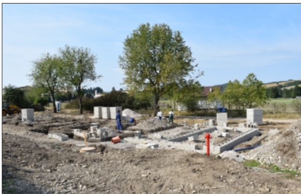
PRÁCE NA ZÁKLADOCH ĎALŠIEHO BYTOVÉHO DOMU
