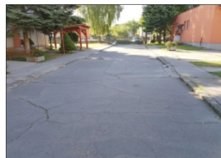
SÚČASNÝ STAV MIESTA REALIZÁCIE DOPRAVNÉHO IHRISKA
