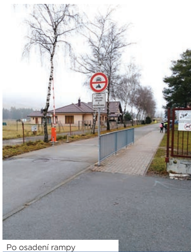
Po osadení rampy
